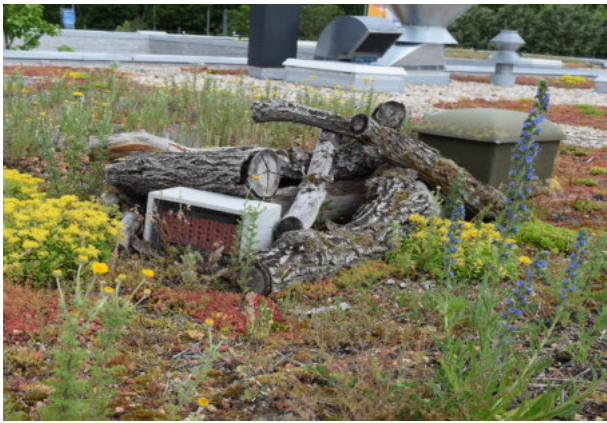
Vorzeigeprojekt in Berlin. Großflächige Extensiv- begrünung aufgewertet mit verschiedenen Bio- diversitätsbausteinen: leichte Anhögelungen mit Stauden, offene Wasser- flächen, Sandlinsen, Totholz und Nisthilfen
