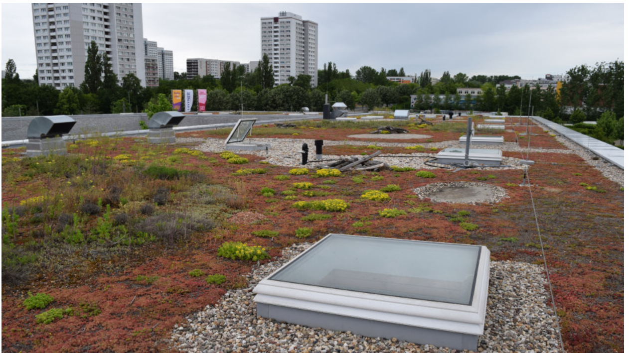
Vorzeigeprojekt in Berlin. Großflächige Extensiv- begrünung aufgewertet mit verschiedenen Bio- diversitätsbausteinen: leichte Anhögelungen mit Stauden, offene Wasser- flächen, Sandlinsen, Totholz und Nisthilfen
