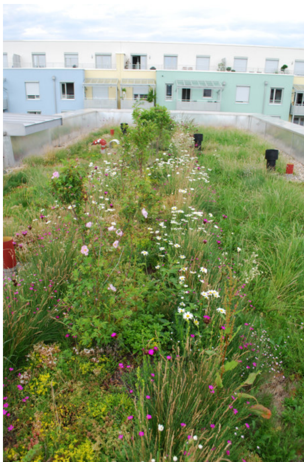
Größeres Objekt in München, bei dem streifenförmig Substratanhügelungen Stauden- und Gehölzpflanzungen ermöglichten
