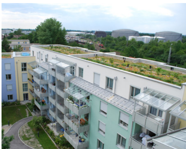
Größeres Objekt in München, bei dem streifenförmig Substratanhügelungen Stauden- und Gehölzpflanzungen ermöglichten
