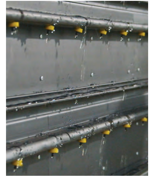
Das Tropfbewässerungssystem wird getestet.
