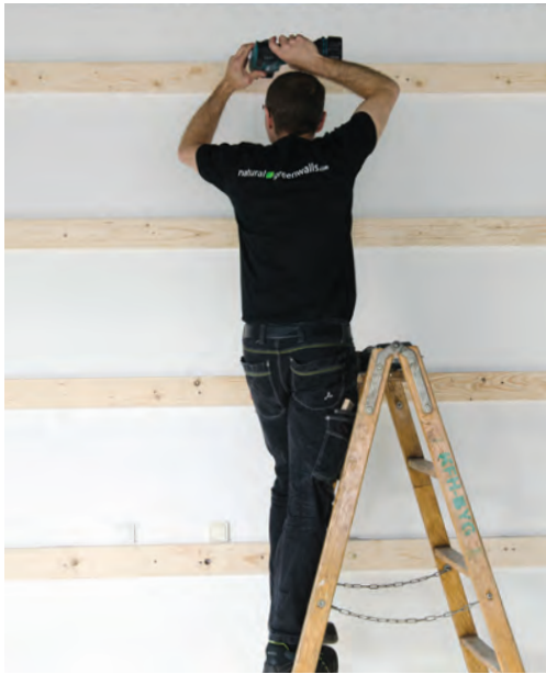
Wir installieren eine Verschalung zur Befestigung der Rückwand.
