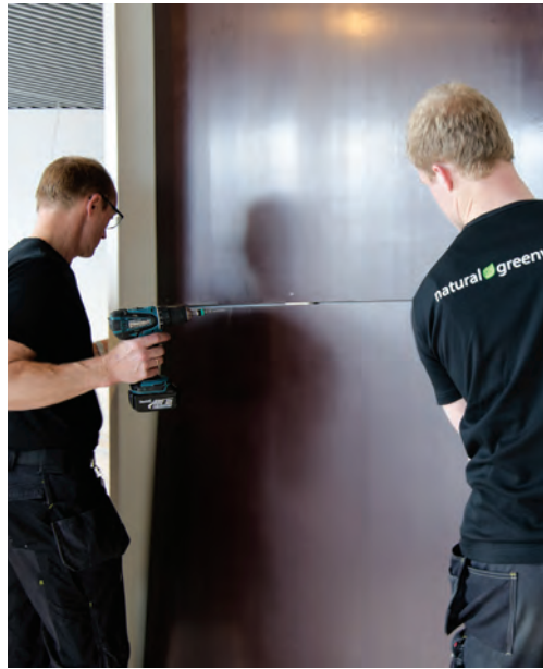
Aufbau der Rückwand mit wasserfesten Platten.
