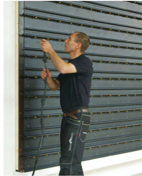
Natural Greenwalls® Schienen werden montiert, Tropfschläuche eingesetzt und die Montage abgeschlossen.
